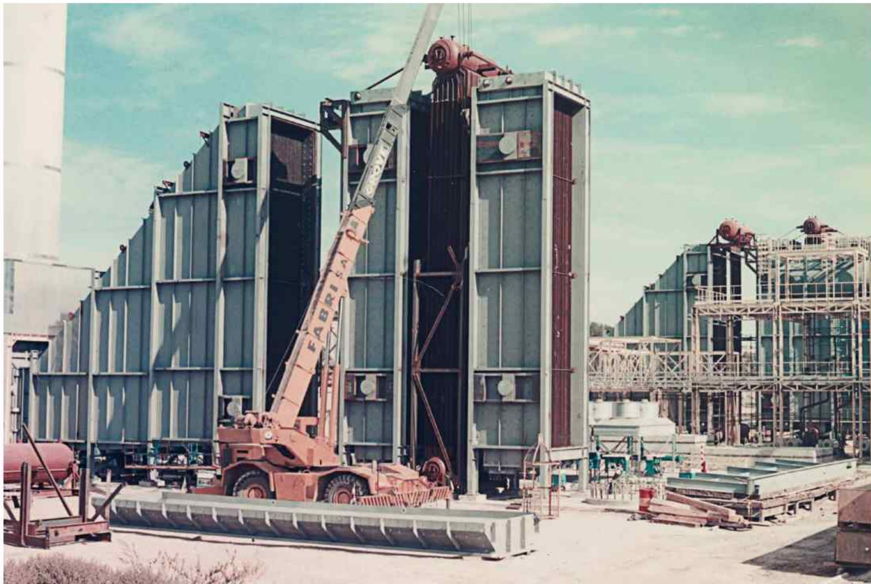
INGENIERÍA. FABRICACIÓN Y MONTAJE DE 2 CALDERAS DE RECUPERACIÓN, HRSG. ALUAR, CHUBUT - FOSTER WHEELER
