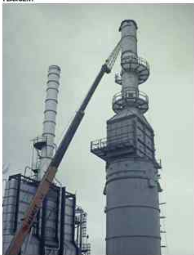
CONSTRUCCIÓN DE HORNO DE CRUDO - PETROECUADOR - FLARGENT
