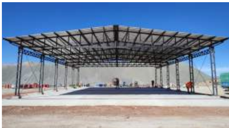
Obra Mina Pirquitas
