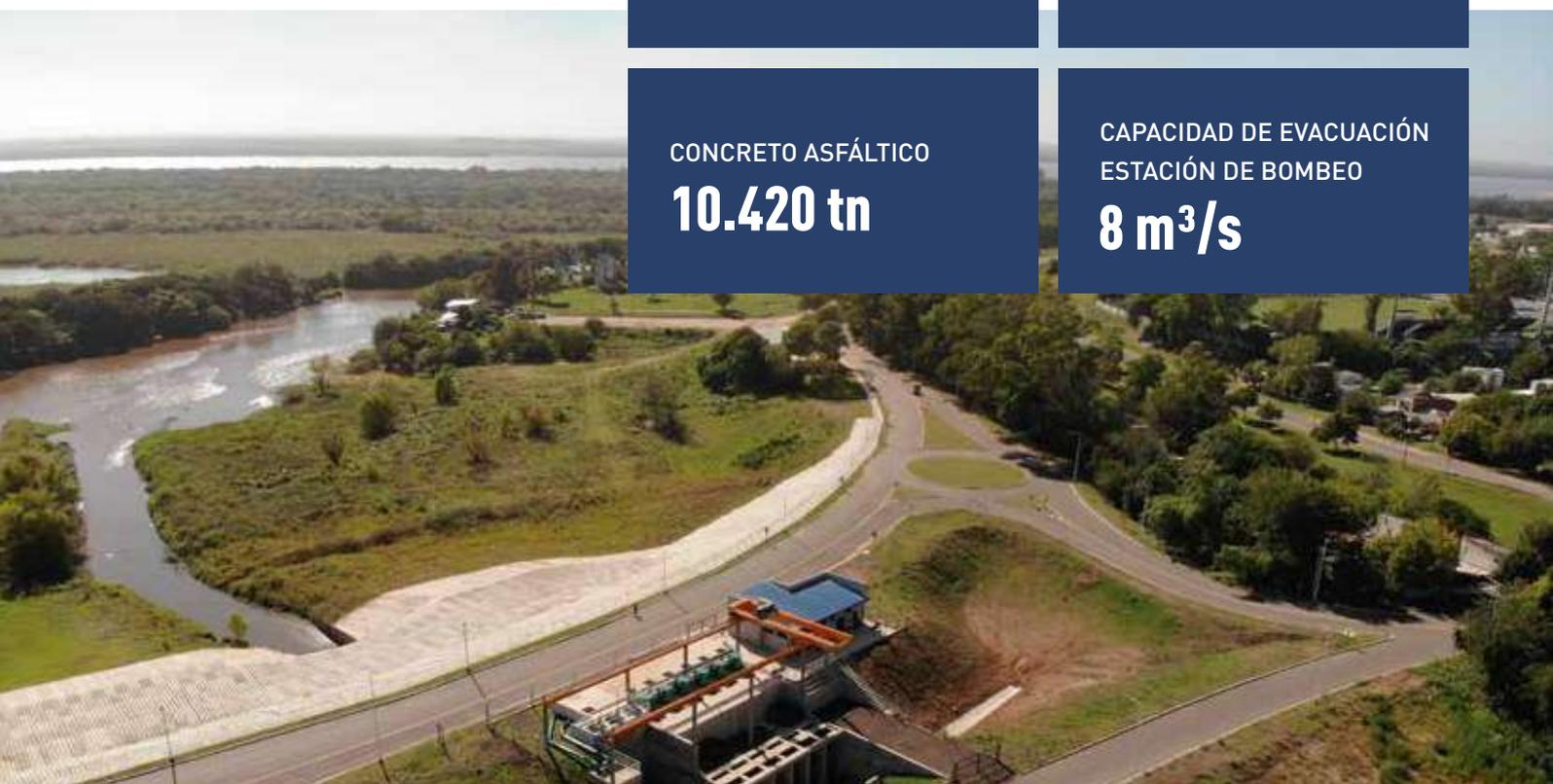
La obra consistió en la construcción de un terraplén de defensa contra inundaciones con elementos viales y arquitectónicos, que incluyen una estación de bombeo con su correspondiente compuerta para evacuación de agua. Asimismo se sustituyó el canal a cielo abierto existente por un conducto pluvial.
