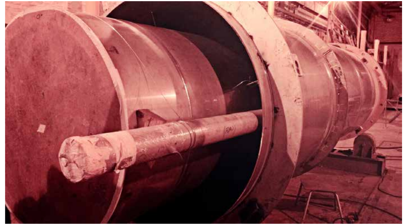
INGENIERÍA Y FABRICACIÓN DE UN TANQUE DE INOXIDABLE PARA DECAIMIENTO DE AGUA PESADA. PROYECTO RA-10. CNEA - INVAP
