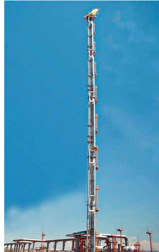
CONSTRUCCIÓN DE UNA ANTORCHA DOBLE DE 145 METROS DE ALTURA. YPF - LUJAN DE CUYO - FLARGENT
