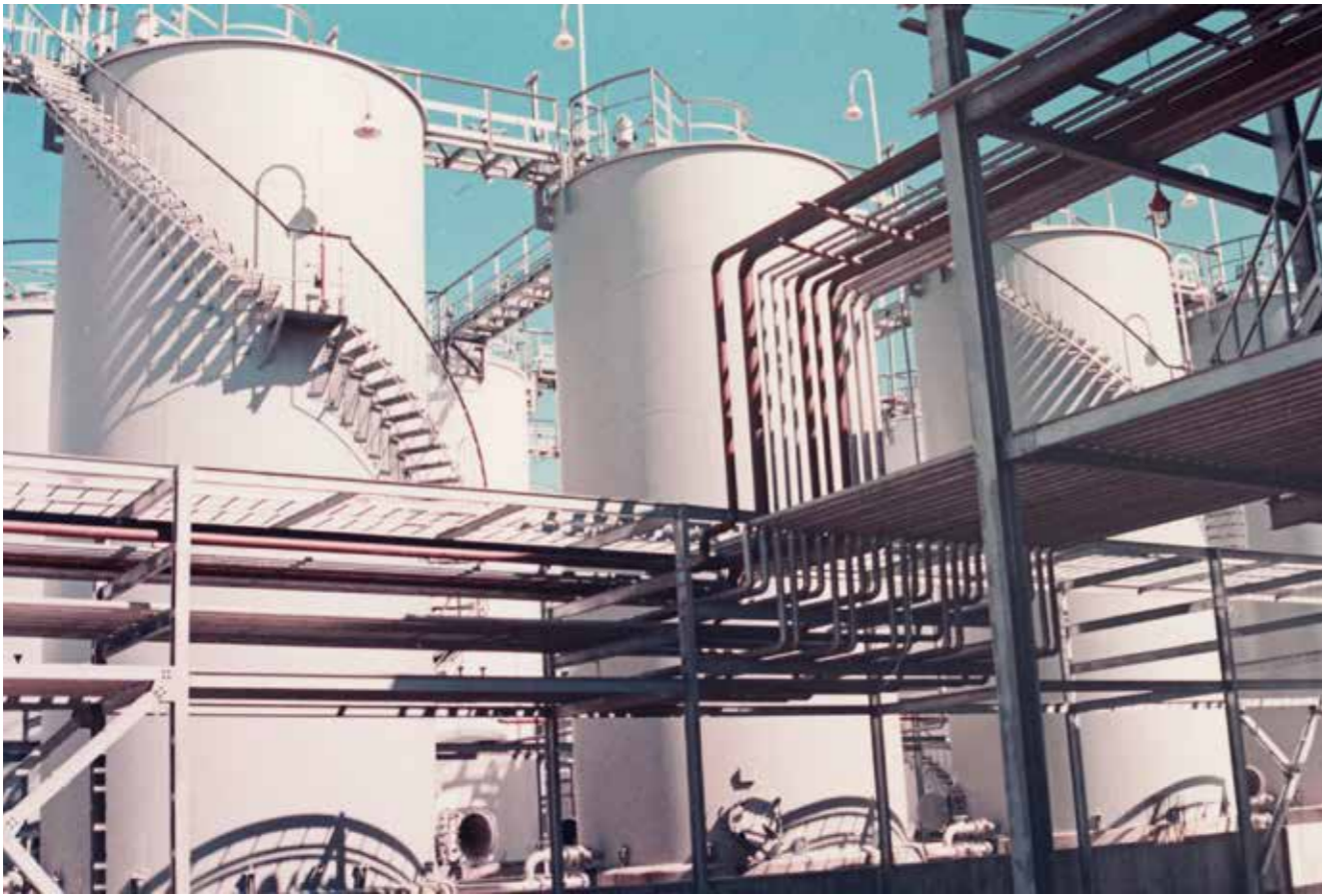
INGENIERÍA, FABRICACIÓN Y MONTAJE DE TANQUES, ESTRUCTURAS Y CAÑERÍAS EN TERMINAL DE ALMACENAMIENTO ODFJELLS TERMINALS - TAGSA CAMPANA
