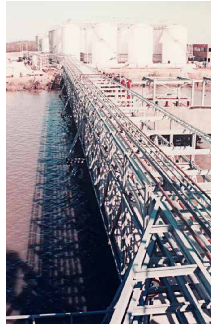
INGENIERÍA, FABRICACIÓN Y MONTAJE DE TANQUES, ESTRUCTURAS Y CAÑERÍAS EN TERMINAL DE ALMACENAMIENTO ODFJELLS TERMINALS - TAGSA CAMPANA
