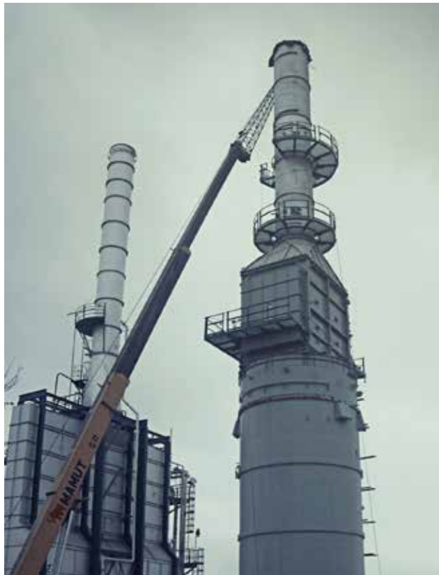
CONSTRUCCIÓN DE HORNO DE CRUDO - PETROECUADOR - FLARGENT
