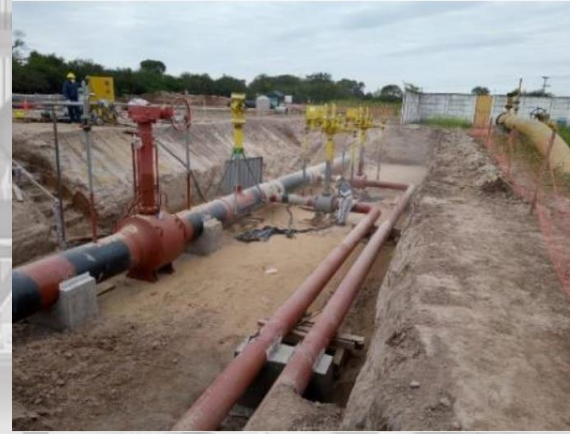
TGN TUCUMÁN Instalación de Trampa de Scraper TR81, Zona Los Romanos, Tucumán.
