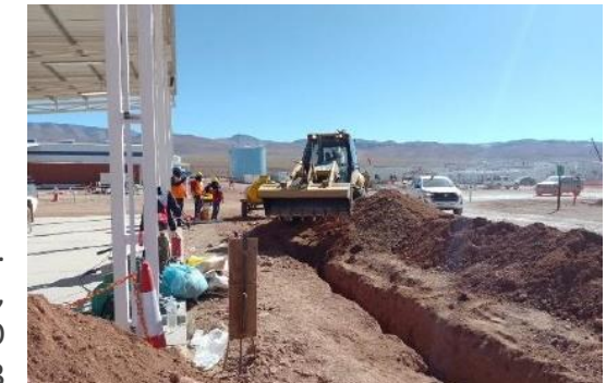
ERAMINE SUDAMÉRICA S.A. Construcción de Red de Incendio, agua, iluminación exterior y otros – BSD-GECO 2023
