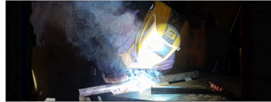
ARMADO Y SOLDADURA
