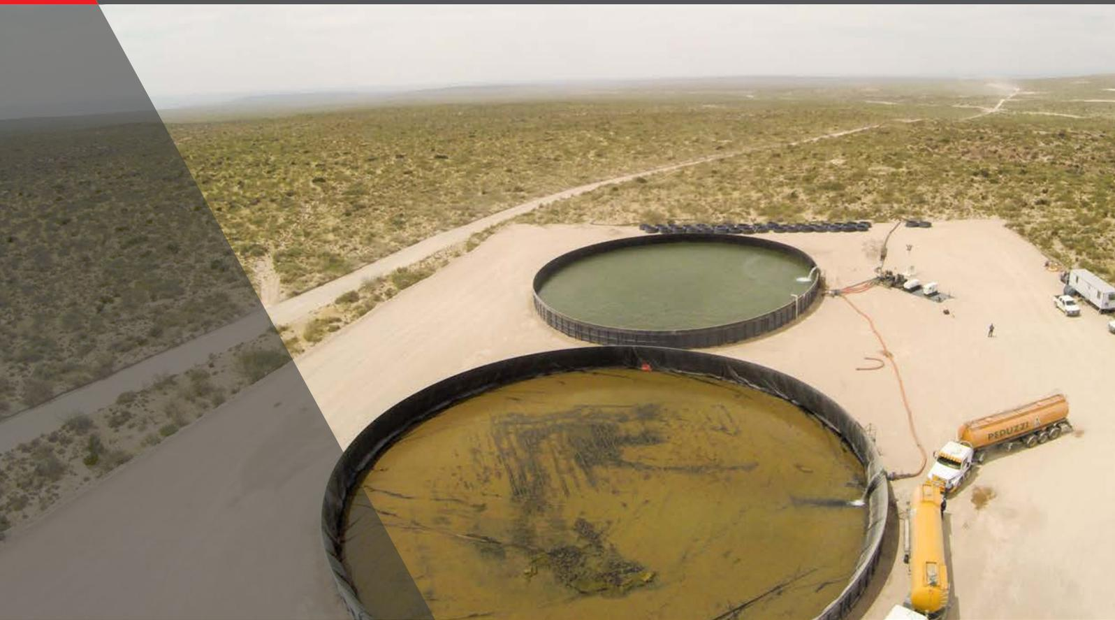
Nuestros tanques son desmontables: pueden instalarse en distintos lugares, y trasladarse las veces que sea necesario. No requieren de pisos ni estructuras fijas.
